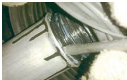
图14 导向定位胶环的安装
