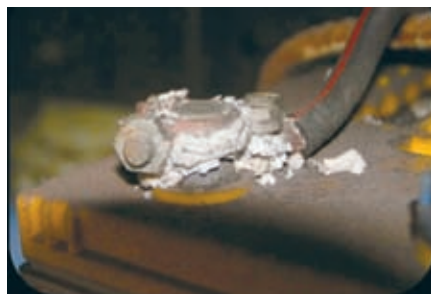
图3 检查蓄电池桩头与导线的情况
