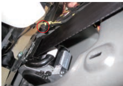
图2 卡箍金属针脚的塑料锁卡断裂
