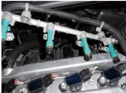
图3 从车上拆下喷油器检查
