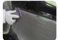
快速平整地打磨中涂面
