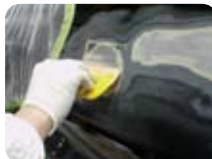
原子灰的有效附着并填平缺陷
